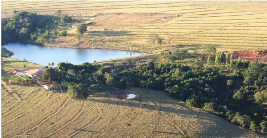
Novo barramento da captação do Piancó é uma das obras programadas, e já teve a contratação do projeto
